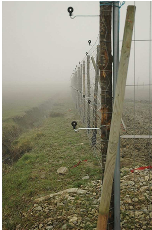
Figura 147 – Recinzione metallica anti-lupo attrezzata con supporti a mensola per il passaggio del filo conduttore
